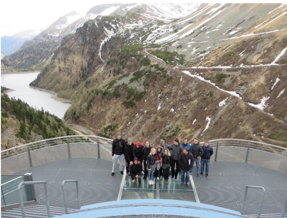
Slika 16: Jez Kölnbrein Staumauer, Malta, Avstrija (foto: Samo Gašperič)
